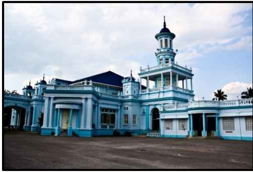
Rajah 2: Bahagian luar bangunan masjid Sultan Ibrahim Muar (Nurulhuda, 2013)
