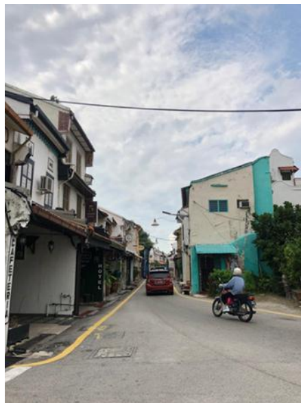
Rajah 5: Keadaan Lorong Hang Jebat yang mempunyai dimensi jalan yang sempit
