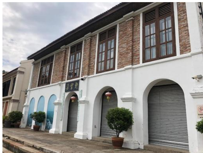
Rajah 4: Bangunan usang yang telah dibaik pulih di pesisiran Sungai Melaka
