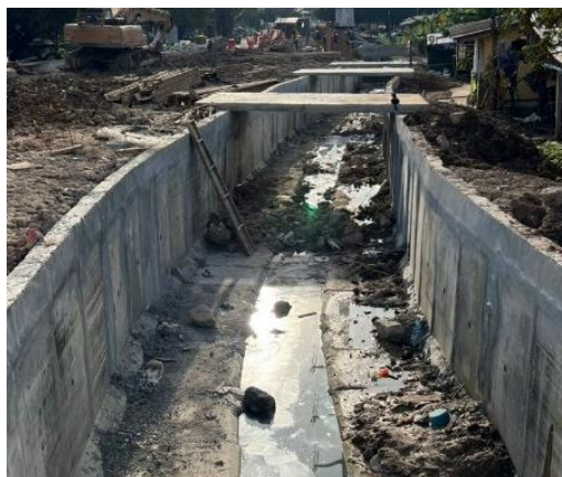
Rajah 1: Sistem saluran permukaan/terbuka
